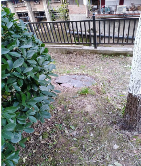
巴中监狱片区污水直排口整治
