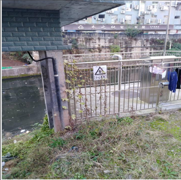
巴州区十小片区污水直排口整治
