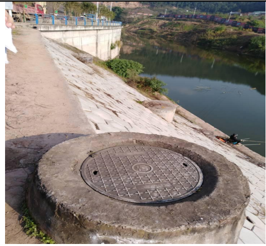
中杨大桥处过河管道整治
