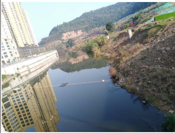
中杨大桥处过河管道整治
