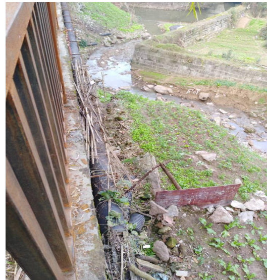
巴中监狱片区污水直排口整治
